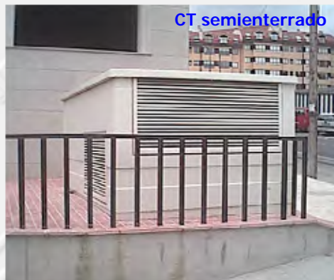
CT prefabricado en hormigón
